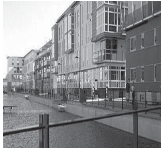
Ett exempel på "kajkantsbyggande" vid Västra Hamnen, Malmö
